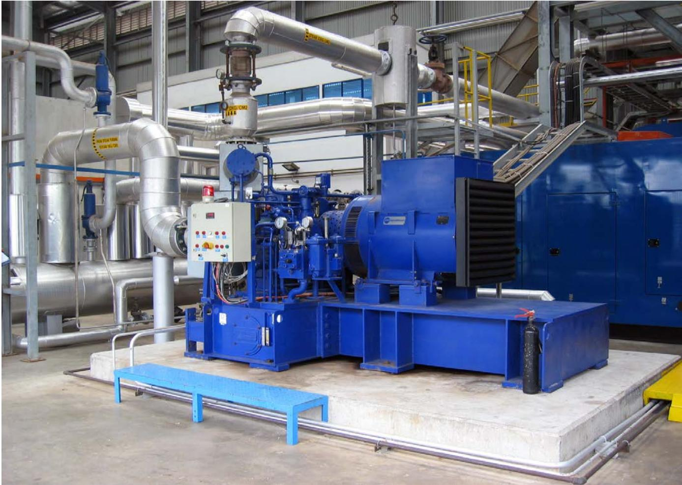
(électricité + chaleur utile) dépendra de la configuration du système et peut atteindre 92%. Le rapport chaleur / électricité d'une cogénération avec turbine peut varier de 1 à 14. Bien qu'un débit minimum de vapeur de 10% de la capacité nominale soit nécessaire pour maintenir l'exploitation de turbines, elles ne peuvent fonctionner de manière fiable qu'à des régimes de 50% à 100%. Cependant, le rendement des turbines fonctionnant à charge partielle est généralement faible.
