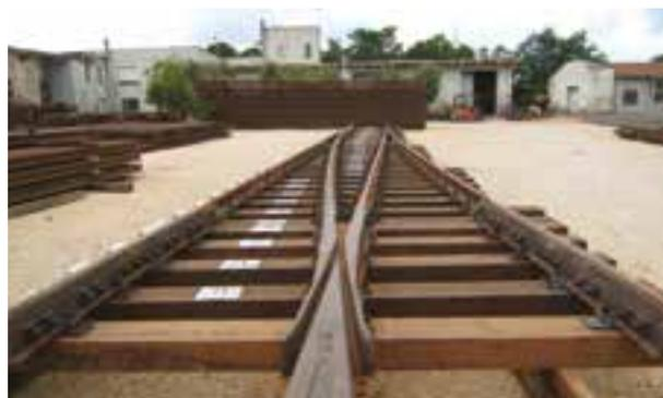
▲ Photo 68 : Traverses d'une ligne d'aiguillage © WIJMA
