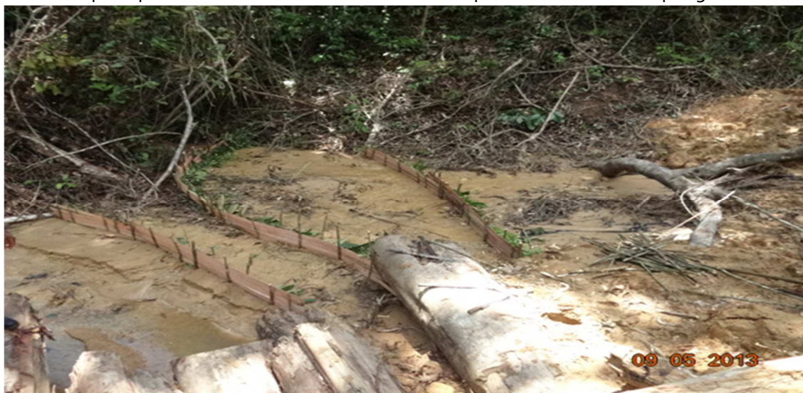
Photo 2 – Languettes de stabilisation des berges et des cours d'eau
