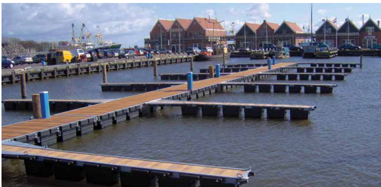
▲ Photo 75 : Ponton de plaisance © WIJMA
