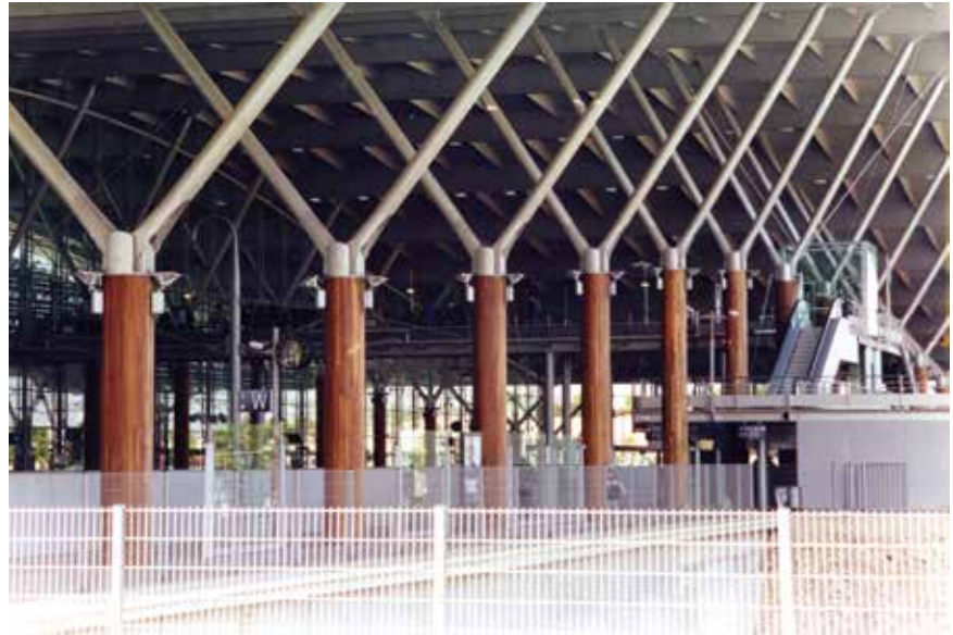
▼ Photo 28 : Poteaux lamellé collé, gare d'Aix en Provence © M. Vernay
