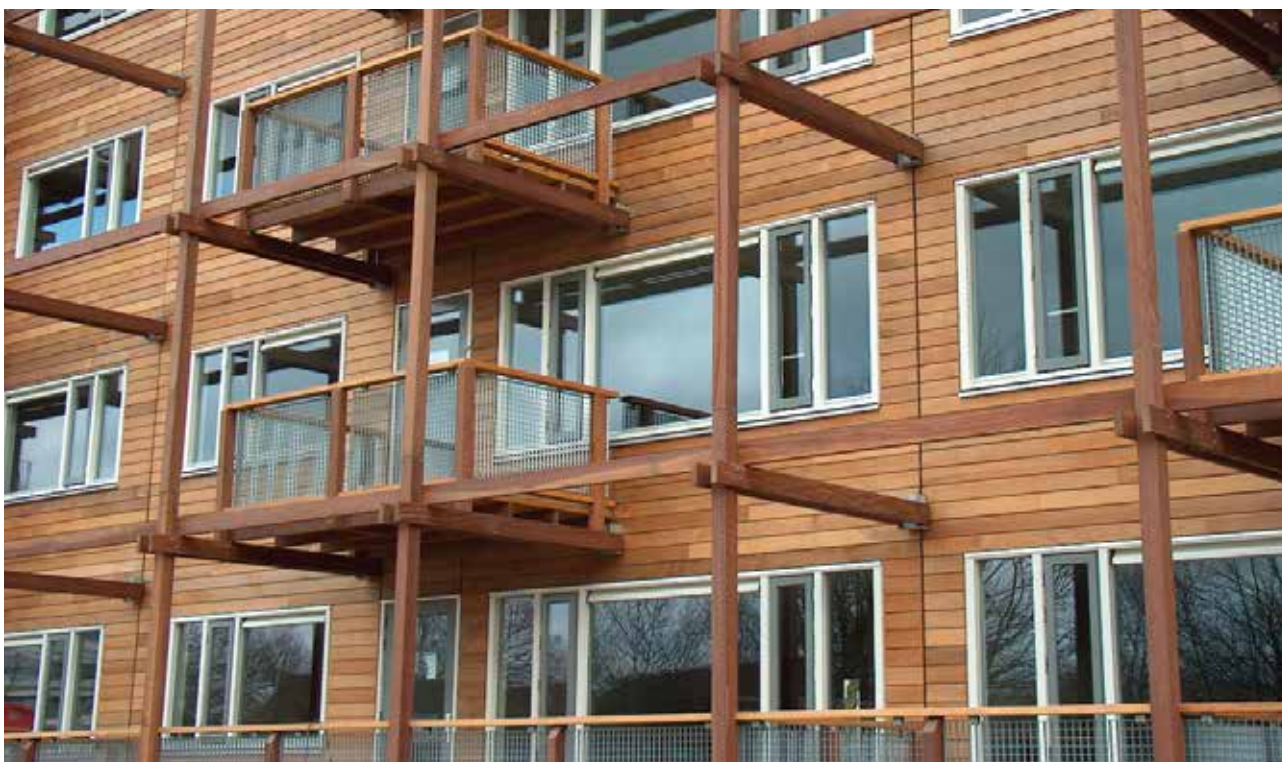
▼ Photo 53 : Structure © WIJMA
