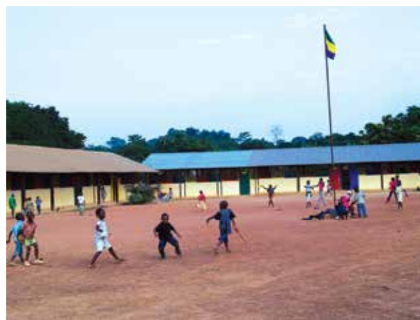
▲ Photo 25 : Ecole construite par une entreprise FSC © B. Demarquez TERE
