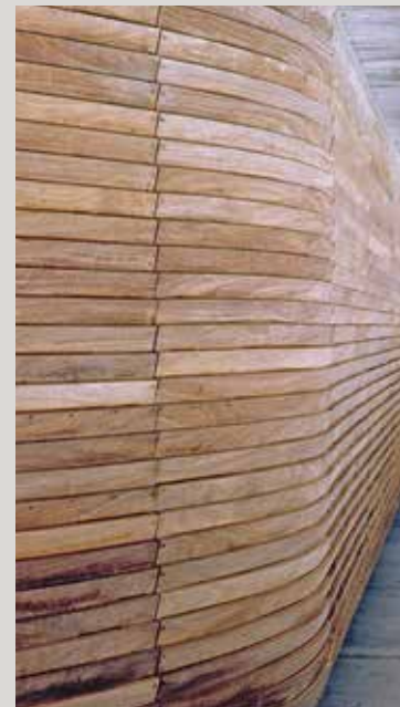
▲ Photo 35 : Aménagement de coursive en bardage bois © M. Vernay
