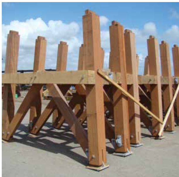
▲ Photo 69 : Charpente lourde © M.Vernay
