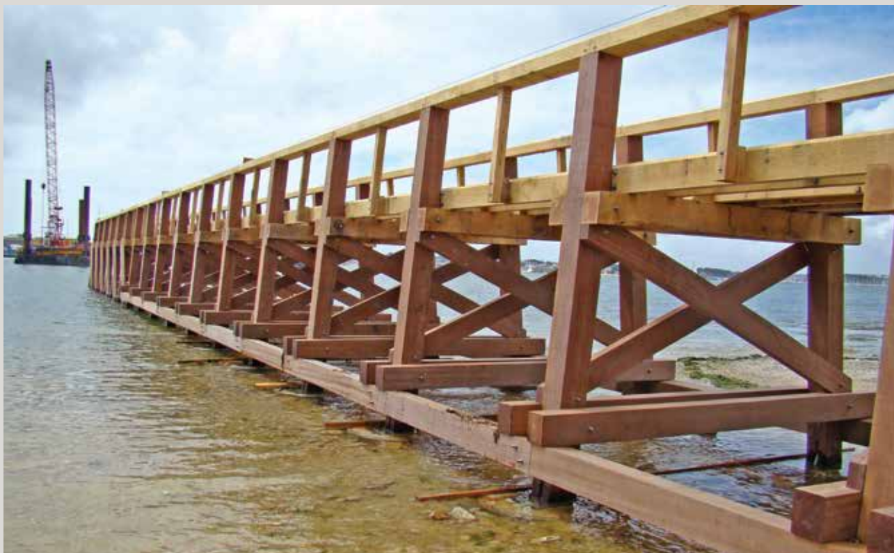
▲ Photo 60 : Estacade © M. Vernay
